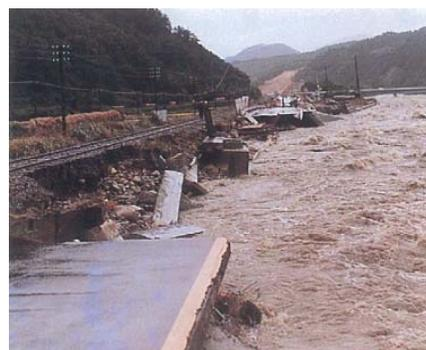
写真 4.1.1 護岸の崩壊により流出した道路
