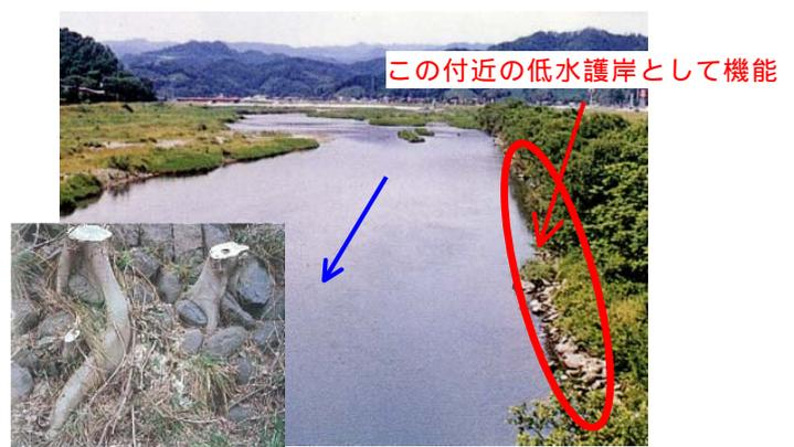
写真 4.2.1 護摩土手の法面の石積と見られる跡と石を抱き込んだヤナギの根(稲常橋上流)
