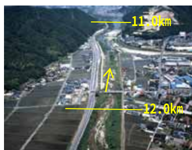
②天神川 12.0km 付近
