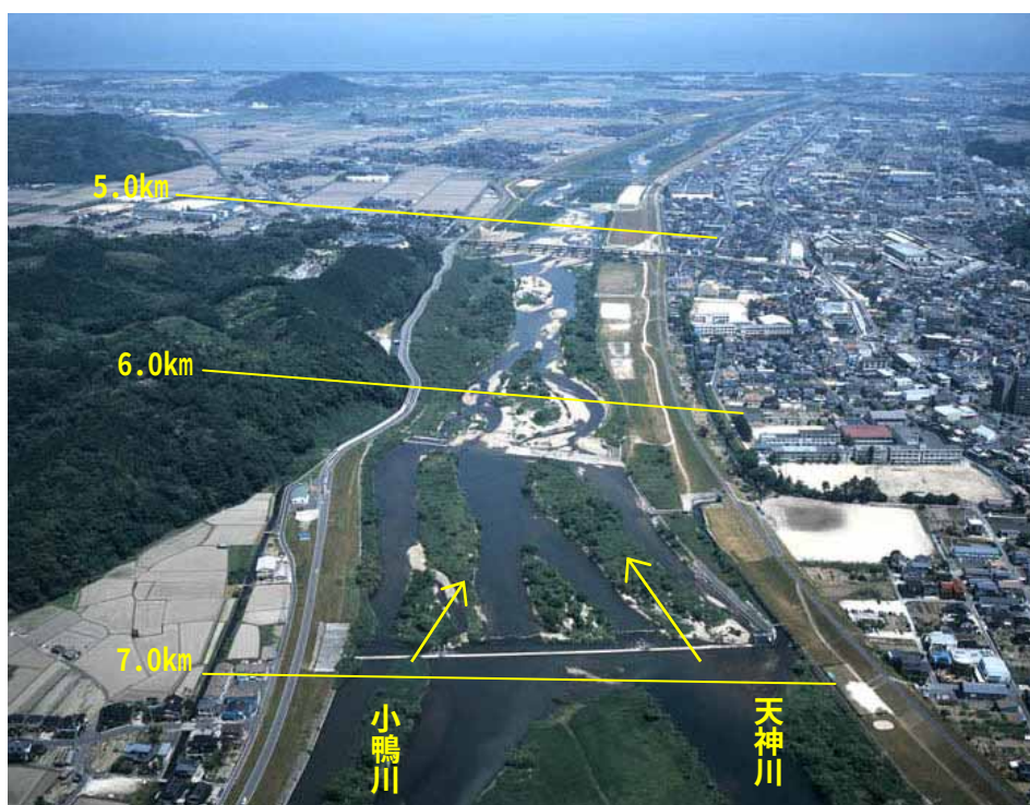
下流部の状況
