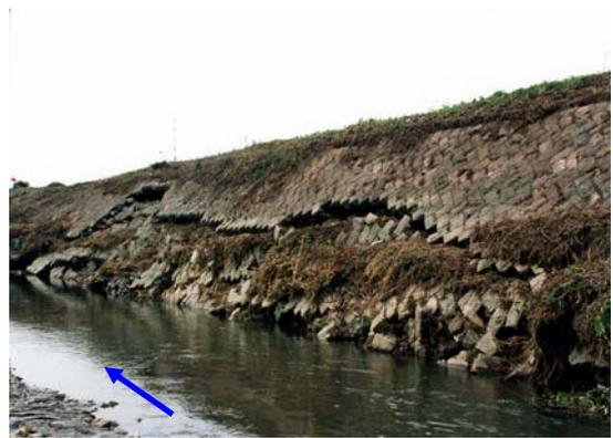
平成 9年 7月洪水での護岸崩壊
