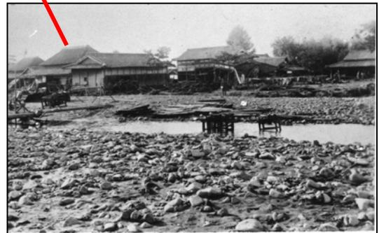
重信川の破堤による田畑への川砂利の流出
