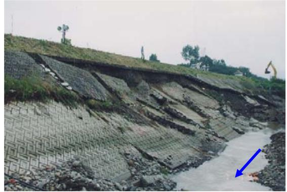
平成 7年 7月洪水での護岸崩壊
