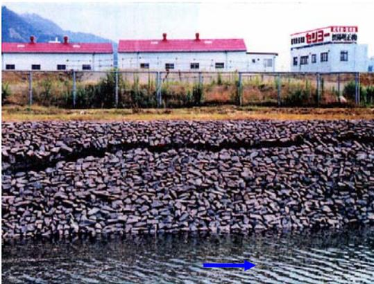
平成 8年 7月洪水での護岸崩壊
