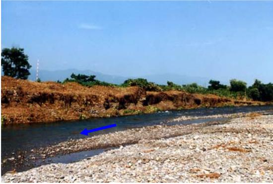
平成元年 8月洪水での河岸崩壊
