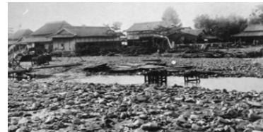
重信川の破堤による田畑への川砂利の流出(松山市久谷地区)
