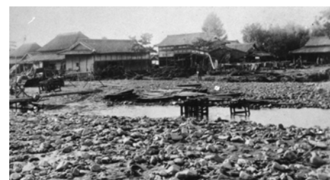
重信川の破堤による田畑への川砂利の流出(松山市久谷地区)
