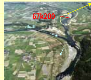
■川辺川合流点付近
