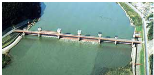
写真上：飯野川可動堰（昭和 7 年竣工） 写真下：北上大堰（昭和 54 年竣工）
