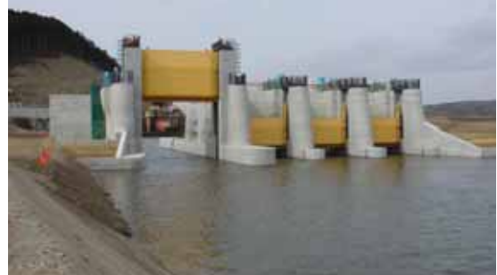
脇谷側水門完成写真
