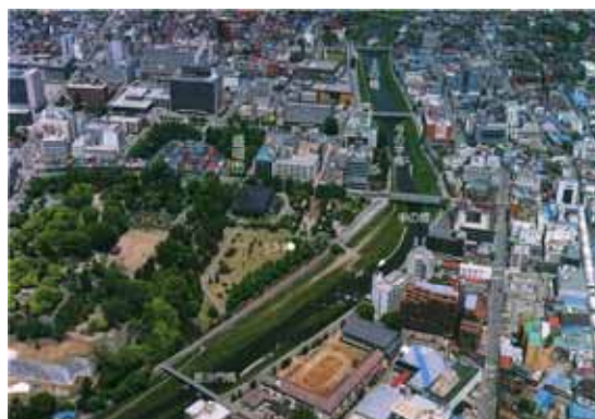
北上川合流点より 1.0km 地点の中津川 市街地を流下しており、遊歩道が整備されている 河川敷はチャグチャグ馬コの洗足の儀の場となっている
