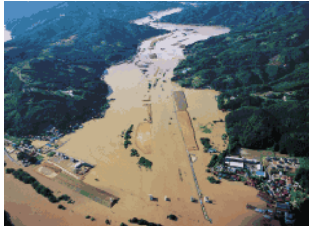
平成14年7月洪水時の浸水状況
