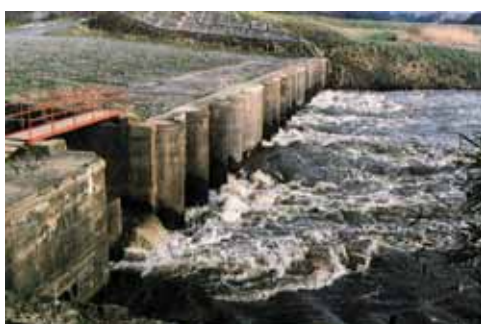
写真上：脇谷洗堰 写真下：鍋波洗堰
