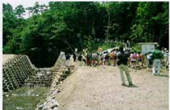
砂防えん堤探検隊
