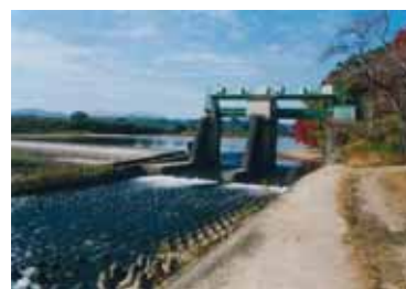
雲出井頭首工（津市・津市一志町）
