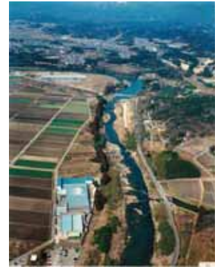
雲出川本川中流 （20km 付近）
