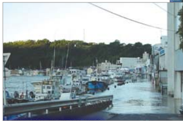
旧北上川浸水状況(石巻市)
