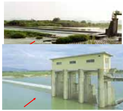
雲出井頭首工
