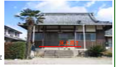
正法寺の浸水位の推定
