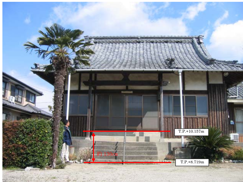
写真 4.1 正法寺浸水記録からの浸水位の推定 (明治3年9月洪水)
