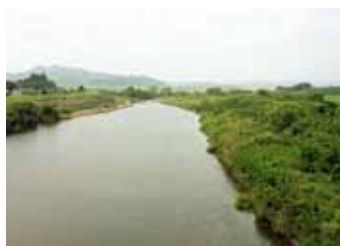
8 広い河川敷のある須賀瀬橋付近
