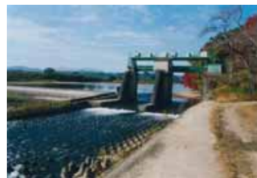
雲出井頭首工（津市・津市一志町）
