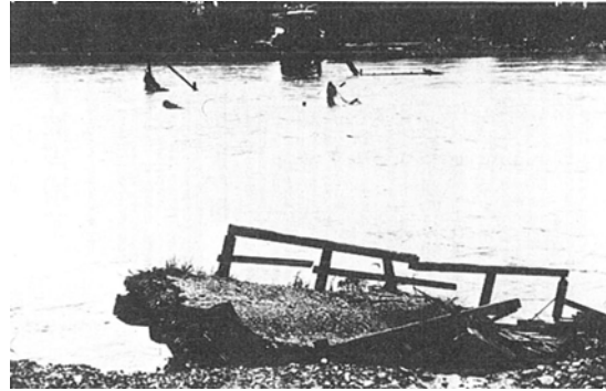
流失した大正橋 昭和 46 年 8 月洪水
