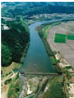
雲出川本川中流 （16km 付近）
