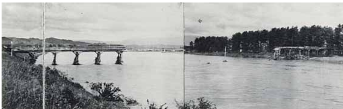
大正橋の落橋（一志郡嬉野町川原小造） 昭和34年9月洪水（伊勢湾台風）
