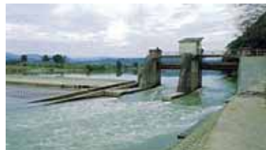
雲出井頭首工
