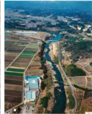
雲出川本川中流 （20km 付近）
