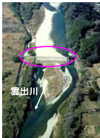
雲出井頭首工
