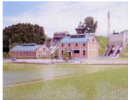
黒東第三発電所の低落差発電
