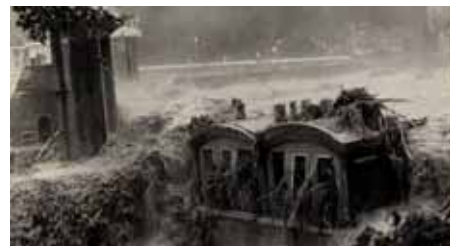
逆巻く濁流(愛本堰堤操作棟)
