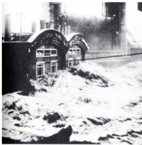
愛本堰堤管理棟より吹き出す流水
