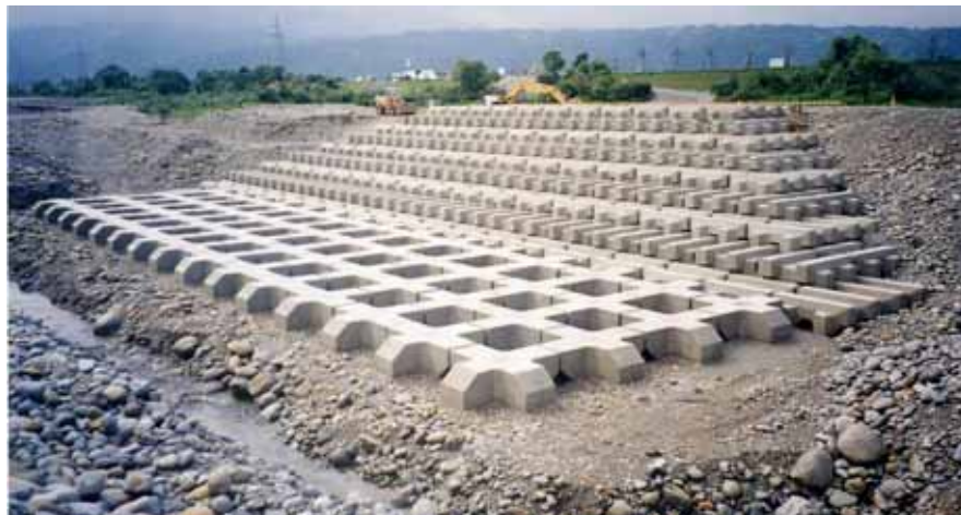
縦工施工状況
