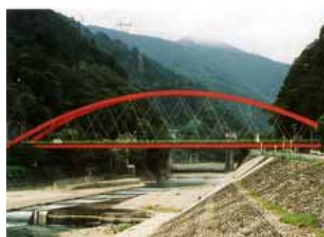
現在の愛本橋（鋼ニールセン型橋）
