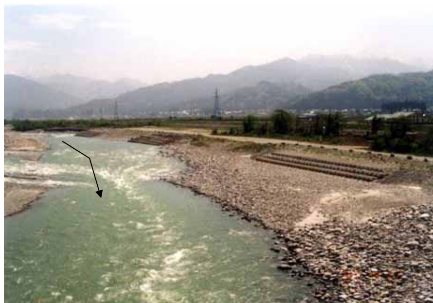
縦工設置状況
