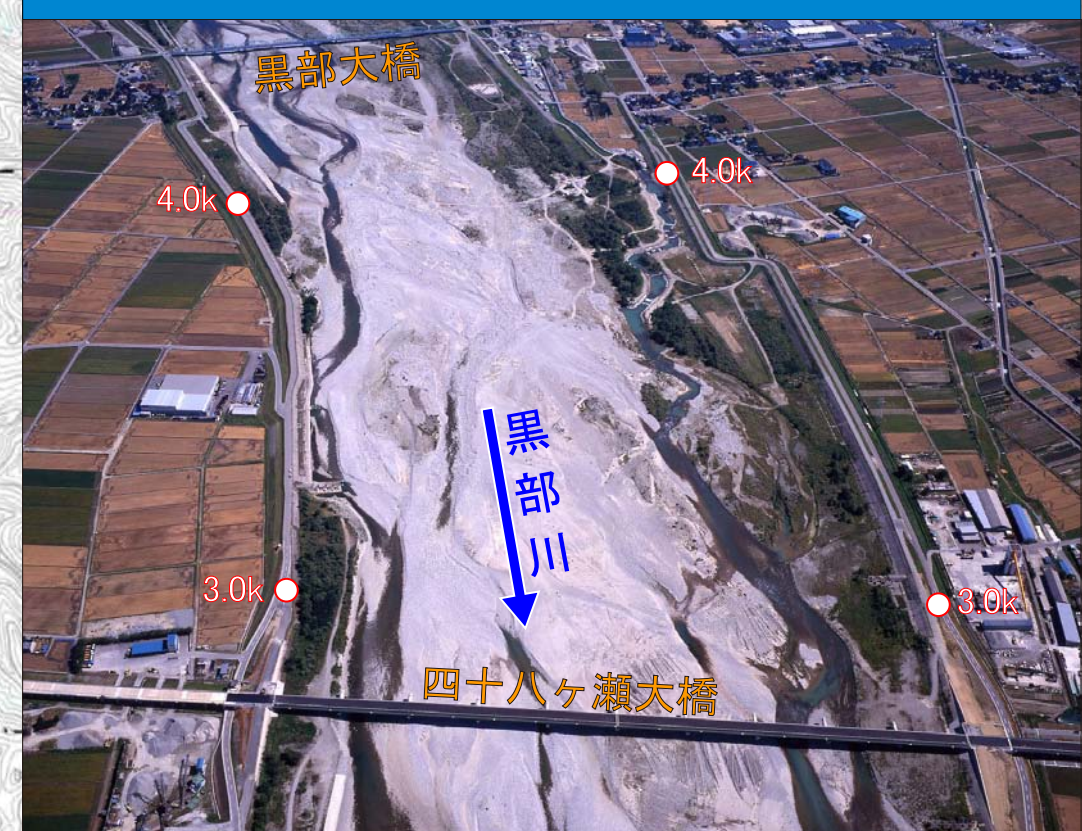
③ 四十八ヶ瀬大橋 (3km付近)
