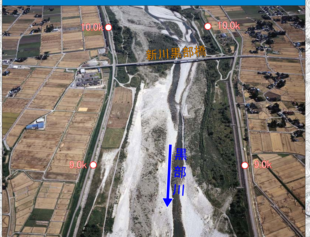
④ 新川黒部橋 (9km付近)
