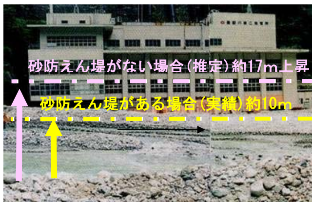
写真 4 砂防えん堤による河床上昇の抑制効果(H7.7 洪水後、黒部川第二発電所付近)
