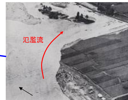
洪水流による破堤状況（福島地先）
