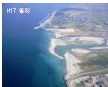
出水(排砂)により一時的に河口部にテラスが発生。
