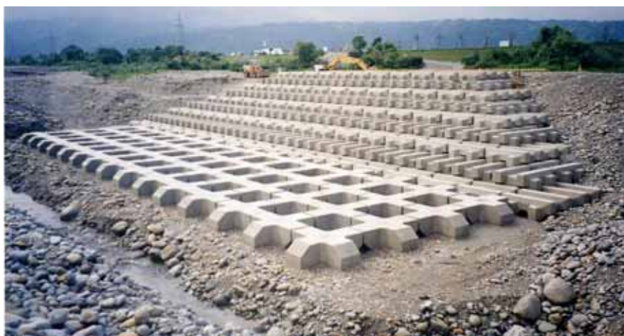
縦工施工状況
