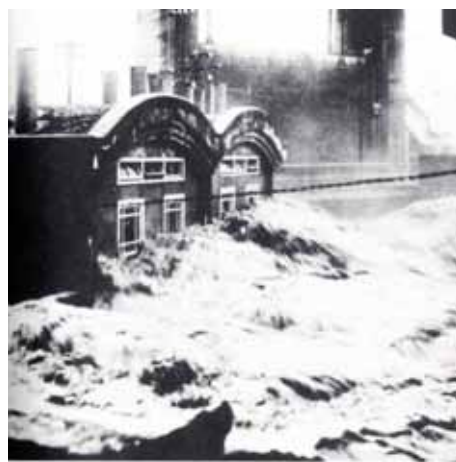
愛本堰堤管理棟より吹き出す流水
