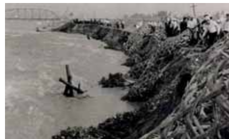
河岸侵食による水防活動実施状況
