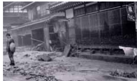
家屋の被害状況（旧 宇奈月町下立）
