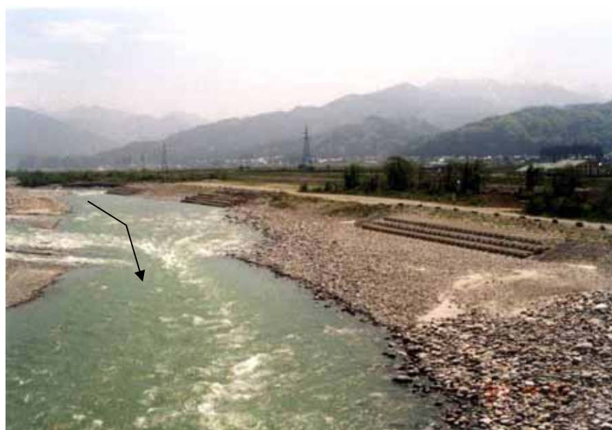
縦工設置状況
