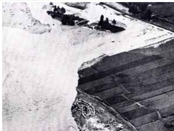
黒部川右岸入善町福島の破堤状況（出水中）
