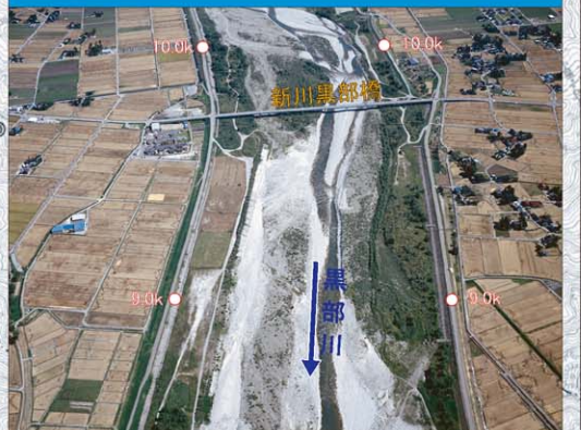
④ 新川黒部橋(9km付近)
