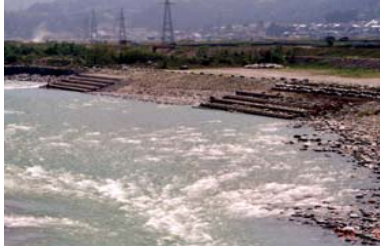
縦工設置状況
