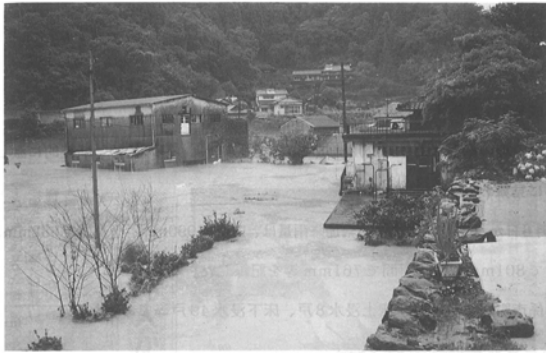
八代市坂本の浸水状況 (八代市 (旧坂本村))
