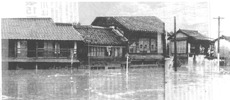
人吉市温泉町の浸水状況 (人吉市)
