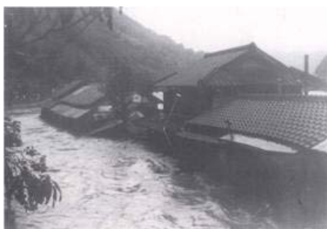
中流部の浸水状況（球磨村神瀬地区）
