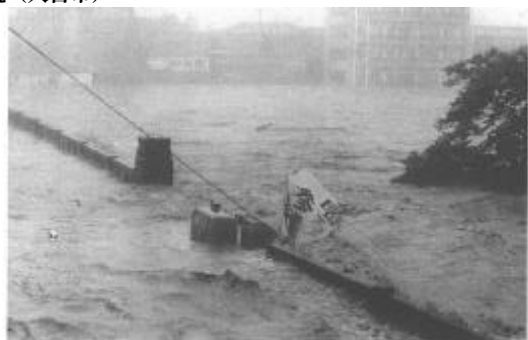
水没した人吉大橋（人吉市）
