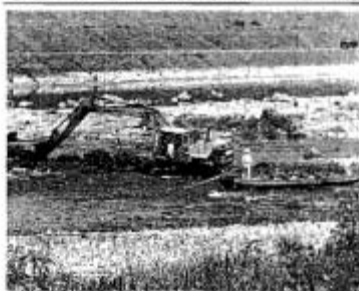
建設重機を使って行われた軌道づくり (天狗橋の上流で)
