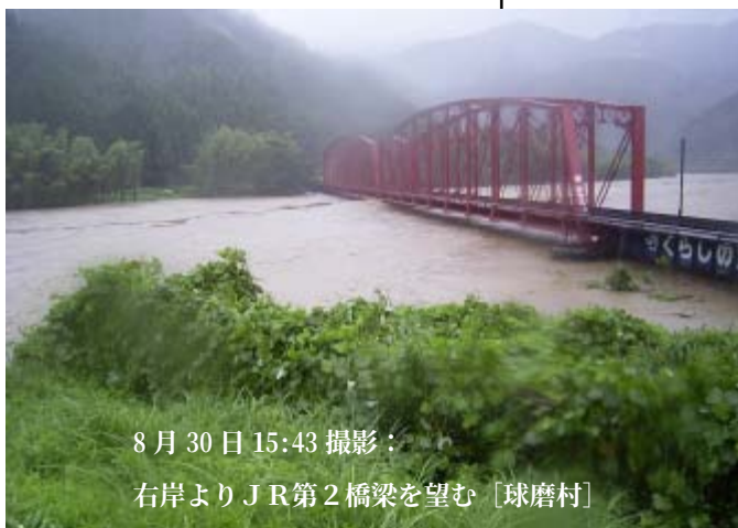
8月30日14:40撮影： 右岸側より人吉大橋桁下を望む〔人吉市〕
