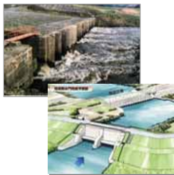
脇谷洗堰（上）と脇谷側水門（下）
