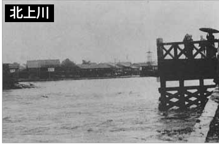
北上川明治橋地点の状況 明治橋が流出
