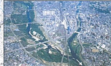
③ 明治橋付近
