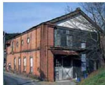
旧東海パルプ地名発電所
