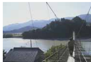
塩郷の吊り橋
