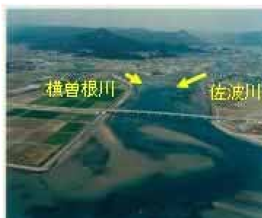
下流部の状況（⑥下流部感潮域空中写真）
