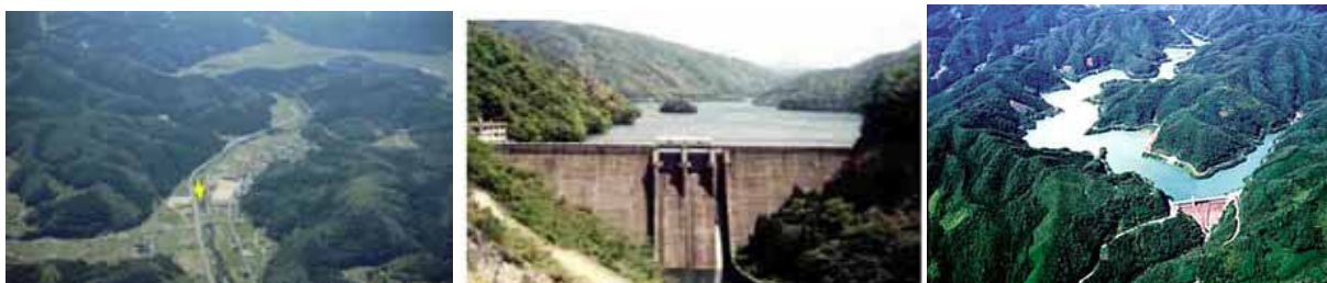
上流部の状況（左：①上流部空中写真、中：②佐波川ダム、右：③島地川ダム）
