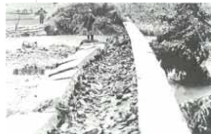
図 4-10 徳地町麻生・麻生頭首工
