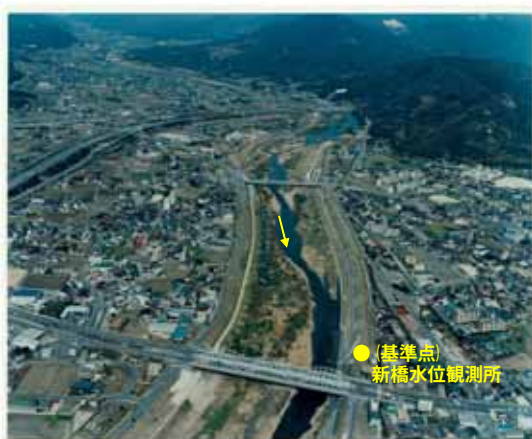
下流部の状況 (⑤下流部空中写真)
