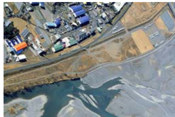
高水敷を新たに造成して堤防を防護
