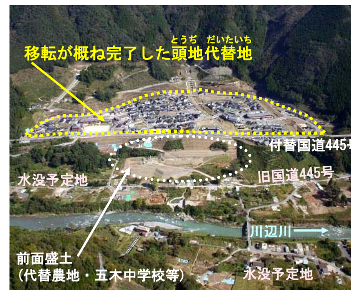
▲頭地代替地移転進捗状況(水没地である五木村中心地)
