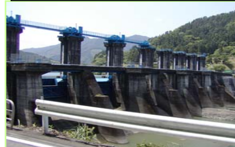
荒瀬ダム（堤高25m）
