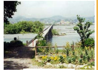
蓬莱橋 (右岸より)
