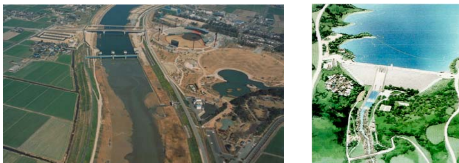
写真 9-3-1 河川管理施設（左：嘉瀬川大堰，右：嘉瀬川ダム）
