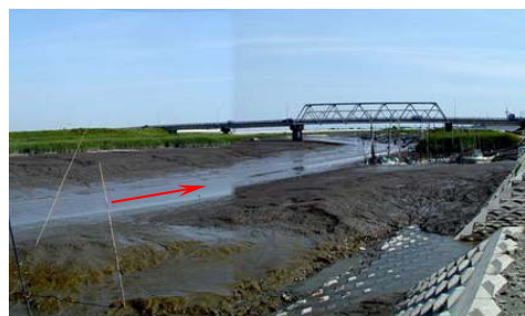
写真 2-2-3 ガタ土堆積状況
