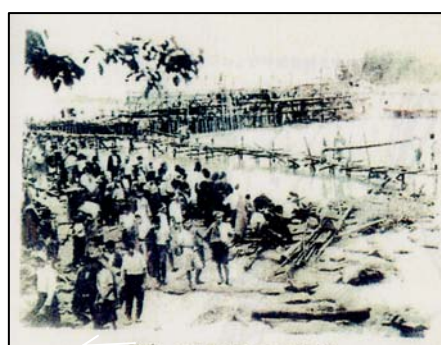
▲決壊箇所の復旧工事
