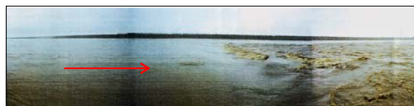
▲徳万堰付近の出水状況
