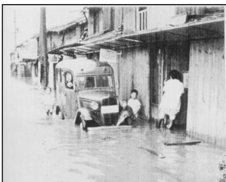
▲佐賀市の浸水状況
