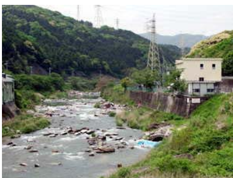
写真5-1-3 川上第五発電所
