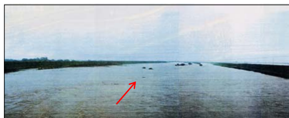
▲池森橋下流の出水状況
