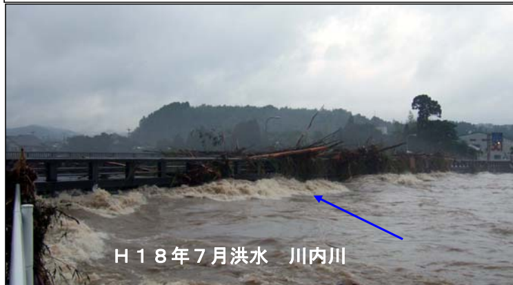
橋梁における流木による洪水流下阻害状況
