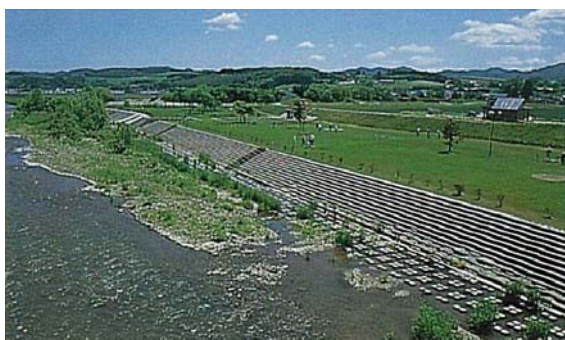
常呂川河川敷(訓子府町)
