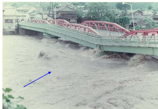
昭和47年7月洪水での香我美橋の橋脚の被災 (香美市神母ノ木地先)
