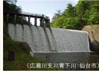
・わずか1kmの間に三つの石張り重力式コンクリートダム
