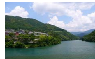
ダムによる湛水部
