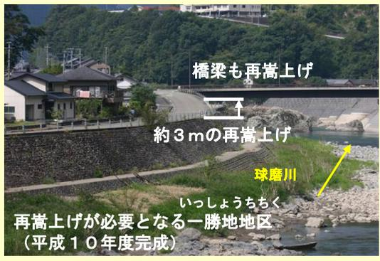
既設の市房ダムで調節し、残りを河道で処理した場合の渡地点の流量8,200 m<sup>3</sup>/s（人吉地点6,800 m<sup>3</sup>/s）に対応するように計画高水位を上げた場合の影響
