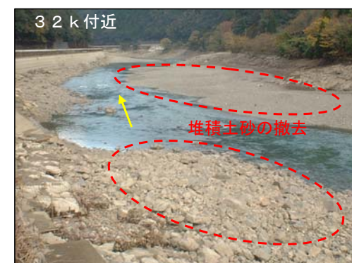
部分的な堆積土砂の除去
