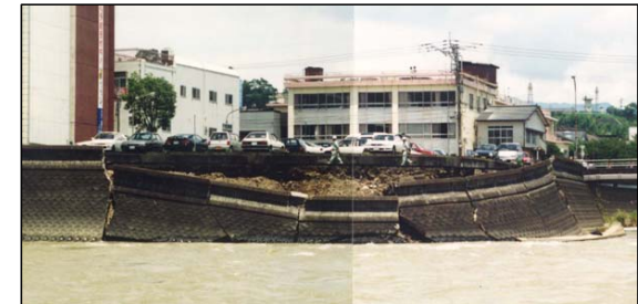
基礎洗掘により護岸が崩壊した球磨川の事例（山田川合流点（H8.7.3～8の出水後）
