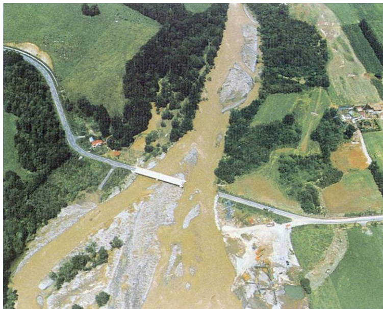
写真 然別川 西瓜幕橋付近の被災状況（鹿追町）
