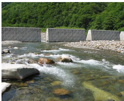
写真 砂防ダム（戸蔭別川）
