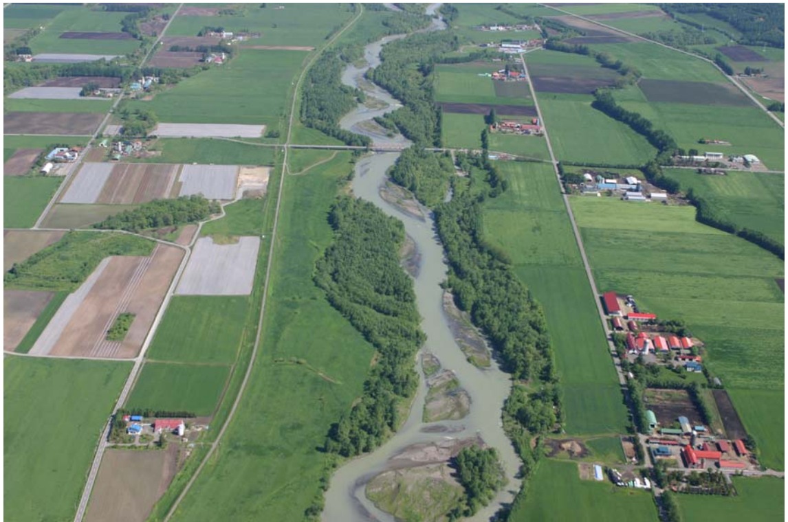
十勝川上流（KP92 付近）
