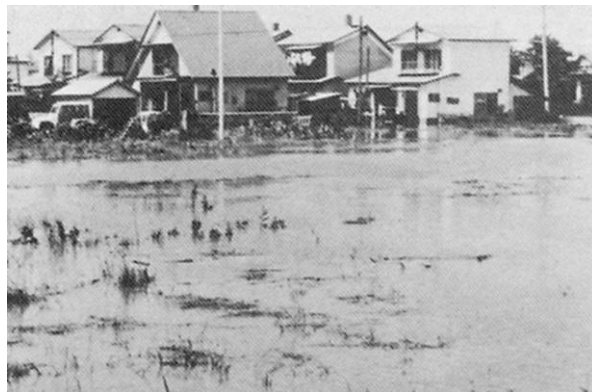
写真 帯広川の溢水氾濫状況（帯広市西 4 条南 2 丁目）
