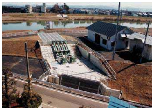
すいとかわ 水戸の川排水機場
