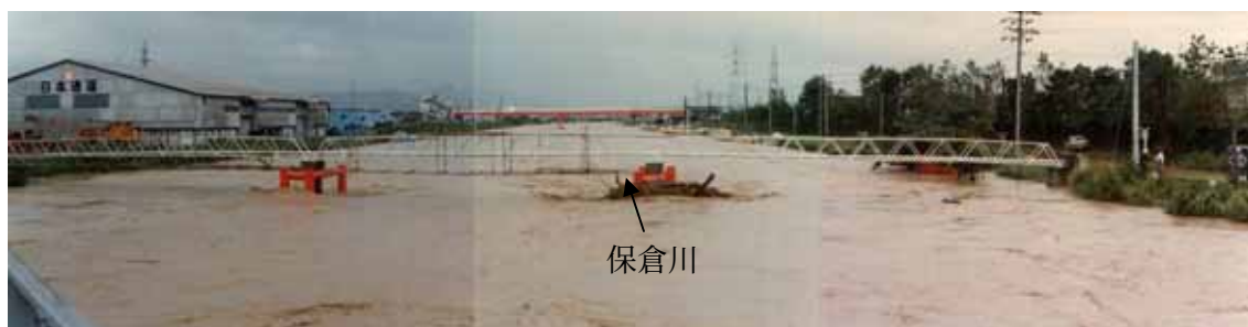
JR 保倉川橋梁より下流を望む
