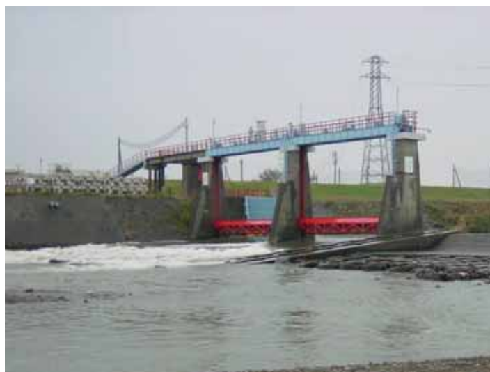
上越工業用水道関川取水堰
