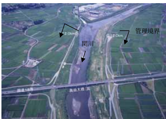
関川直轄区間上流付近
