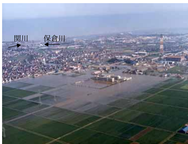
上越市福田地先湛水状況
