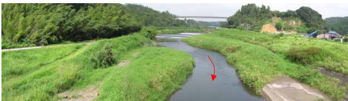
串良川林田橋（8 k 835）より上流
