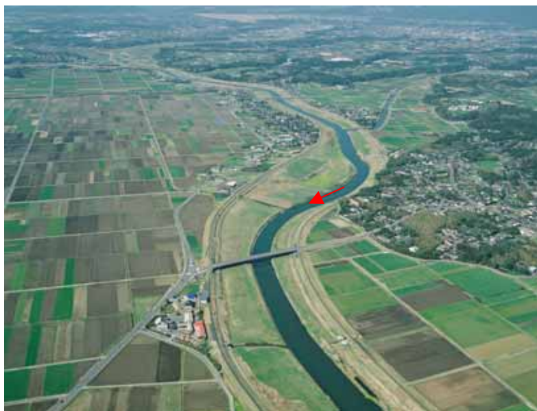
【肝属川中流部（永田橋付近）】
