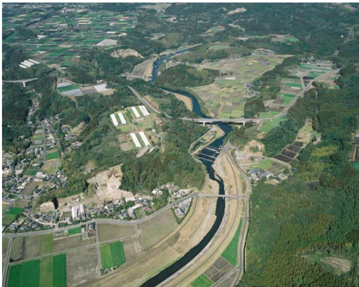
写真 8 - 7 串良川（林田堰付近：9 km 付近）
