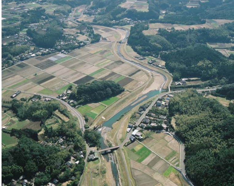
写真 8 - 9 始良川（鶴峯床止付近：6km 付近）
