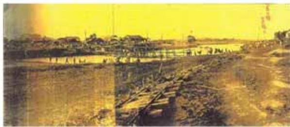
高山川 2/300 付近（高山橋）被害状況
