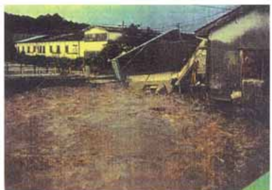
下谷川（田崎橋下流左岸）被害状況
