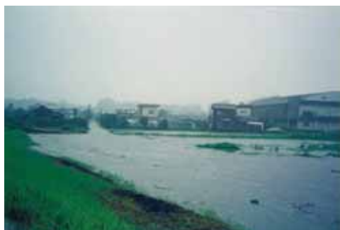
高山川左岸 2/000 付近（高山町内） 被害状況
