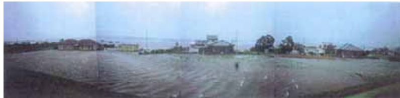
肝属川右岸 8/600 付近（堤内地の状況）
