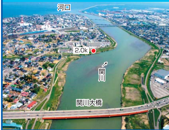
② 関川大橋下流
