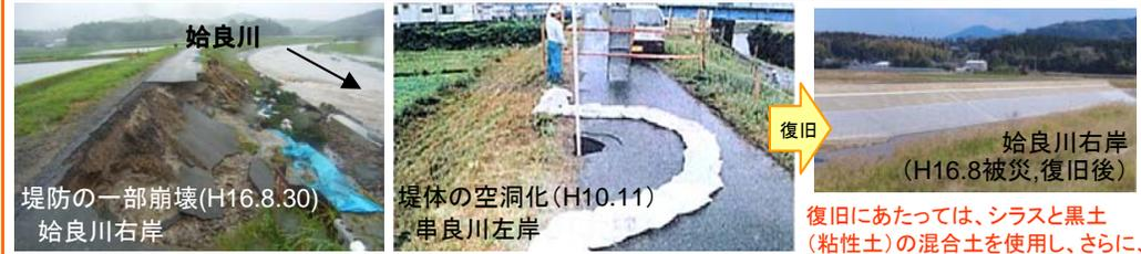
堤防のり面の侵食により堤防が崩壊。
