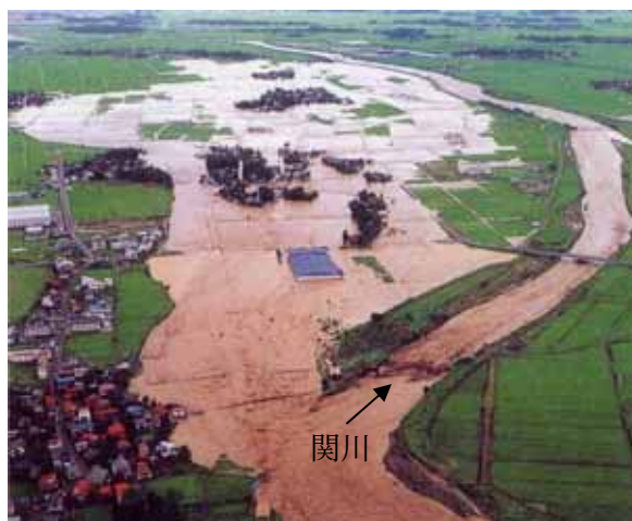
新井市月岡地先破堤状況
