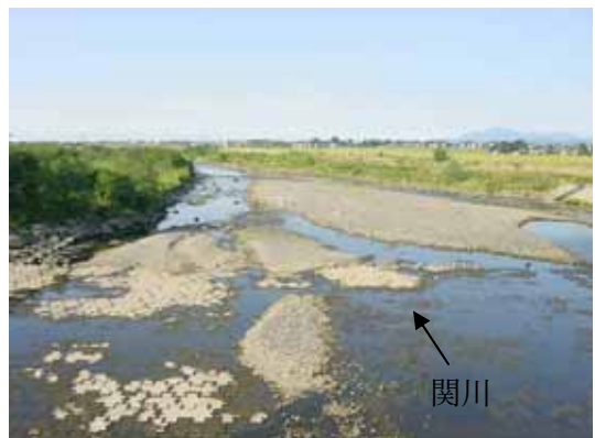
関川頭首工より下流を望む（妙高市）
