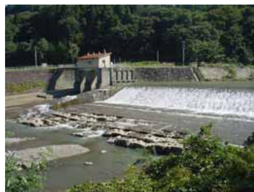
板倉発電所取水堰堤
