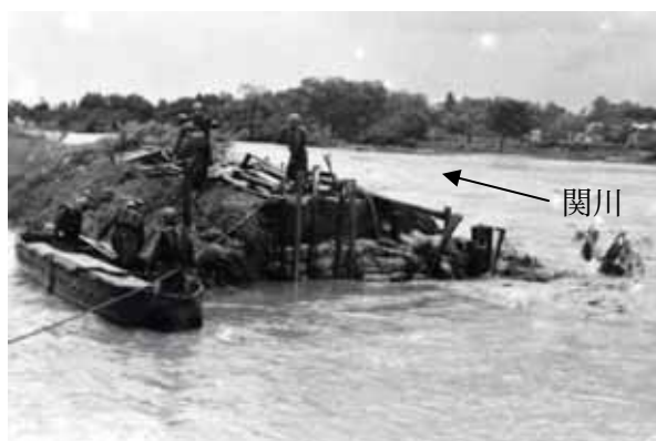
中央橋左岸破堤状況
