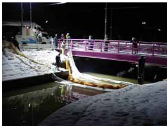
オイルフェンス設置状況
