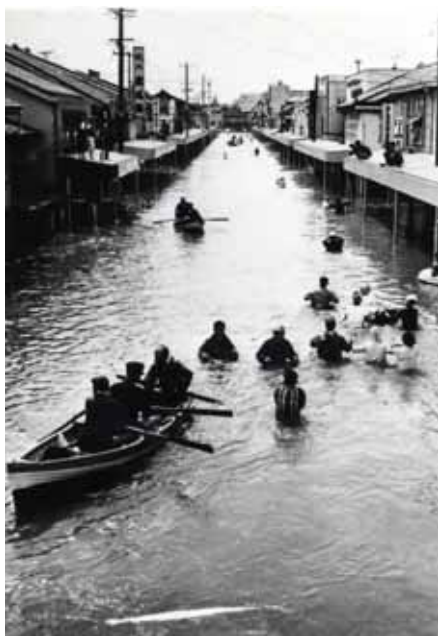
直江津駅前浸水状況
