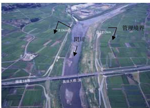
関川直轄区間上流付近
