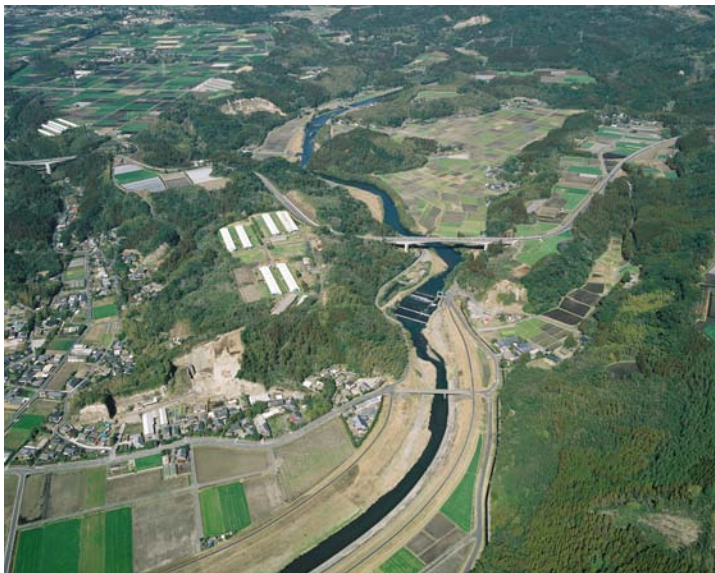
写真 8 - 7 串良川（林田堰付近：9 km 付近）
