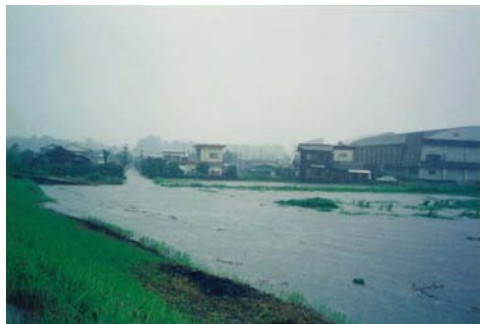
高山川左岸 2/000 付近（高山町内） 被害状況
