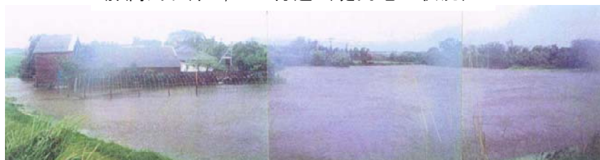
串良川左岸 0/600 付近（堤内地の状況）
