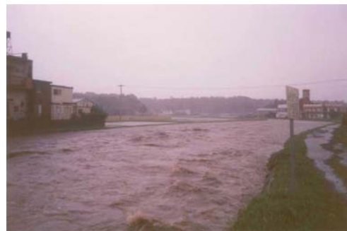
肝属川 20/000 付近（王子橋下流） 被害状況
