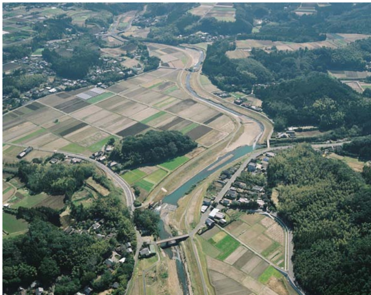
写真 8 - 9 始良川（鶴峯床止付近：6km 付近）
