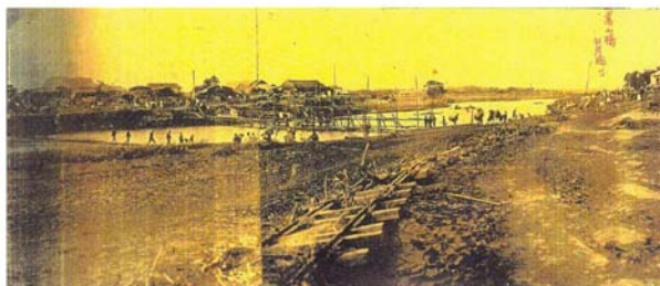
高山川 2/300 付近（高山橋）被害状況
