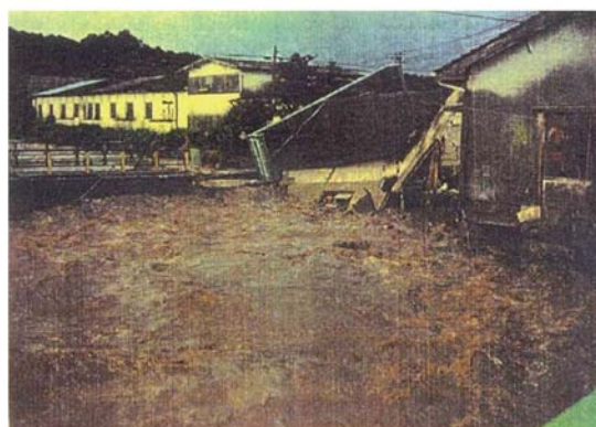
下谷川（田崎橋下流左岸）被害状況
