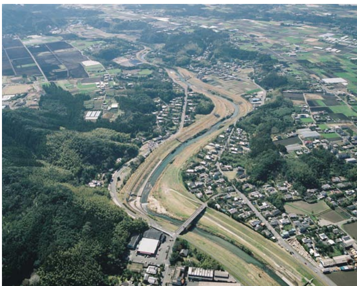
写真 8 - 8 高山川（高山橋付近：3.4k 付近）
