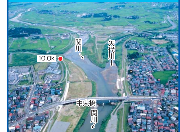
⑥ 関川、矢代川合流付近
