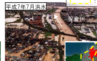
H7.7出水被害状況
