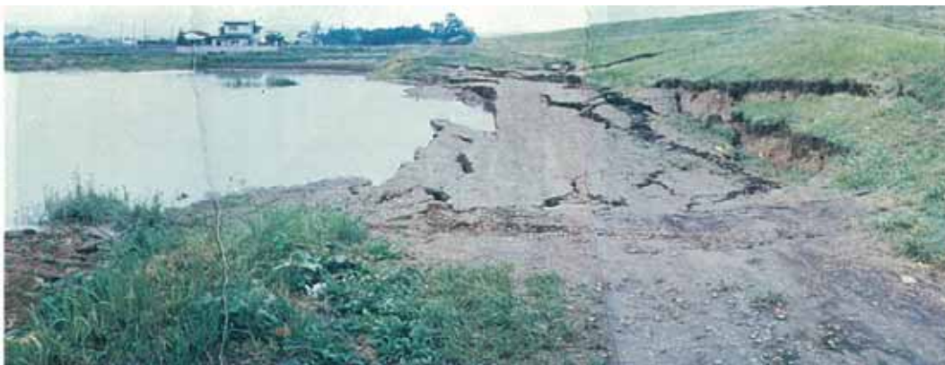
▲千代大橋橋脚上部のコンクリート剥離と鉄筋座掘(上左) 堤防天端縦断亀裂と特殊堤の傾斜 名取市関上(上右) 堤防裏法面のすべりによる亀裂 名取川右岸・名取市鍋沼(下)
