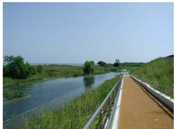
図 8.4.4 平成 13 年 8 月 23 日の河口閉塞による河口部右岸の親水施設の冠水状況
