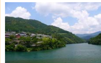
ダムによる湛水部
