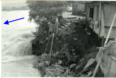
○昭和45年8月洪水 深淵流量：約4,600m³/s(戦後最大) 左岸7k/0付近の河岸の侵食
